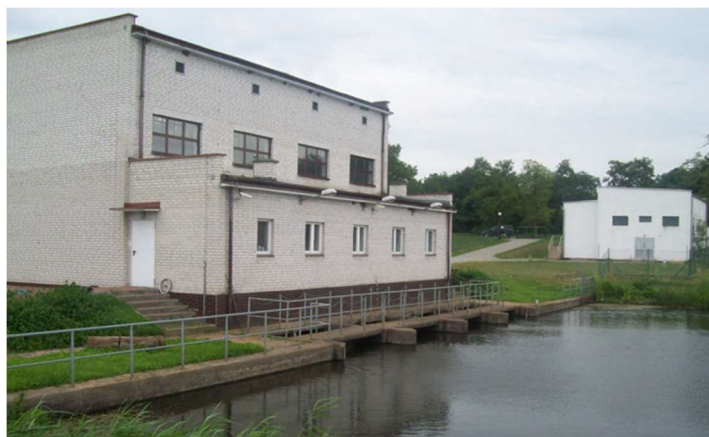
Fot. 22 Pompownia Warniki II
