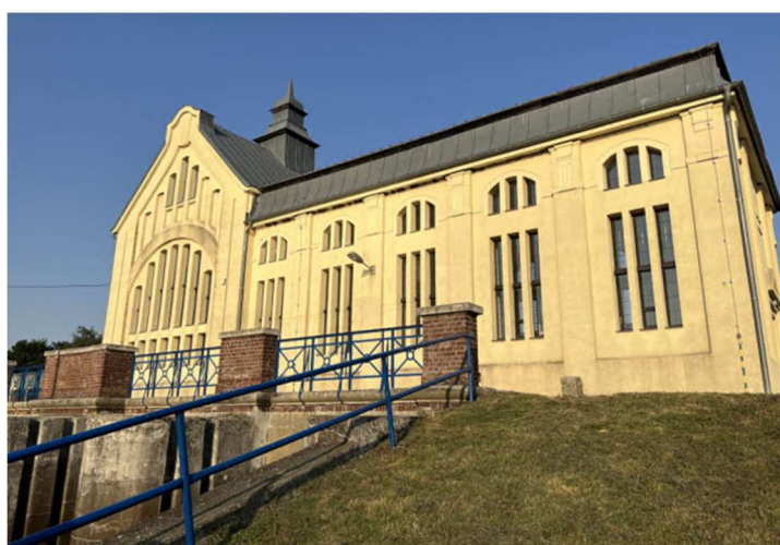
Fot. 21 Pompownia Słońsk I
