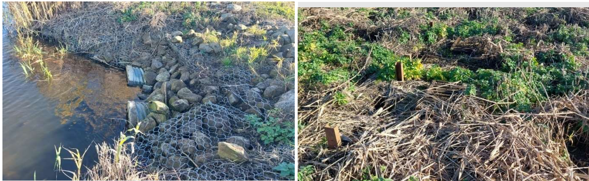
Fot. 9 Ujęcie wody powierzchniowej (źródło: opracowanie własne).
