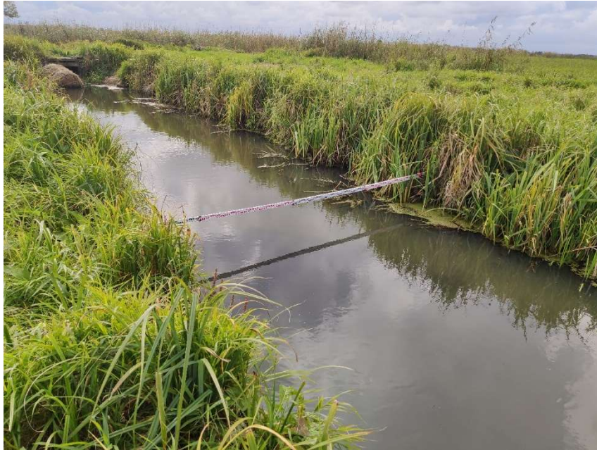
Fot. 18 Kanał Maszówek - inwentaryzacja terenowa: stan techniczny – utrzymany.
