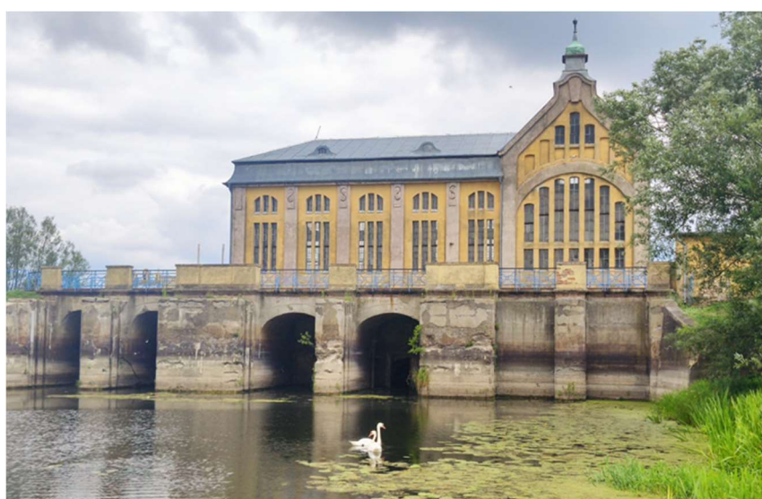
Fot. 13 Pompownia Warniki I
