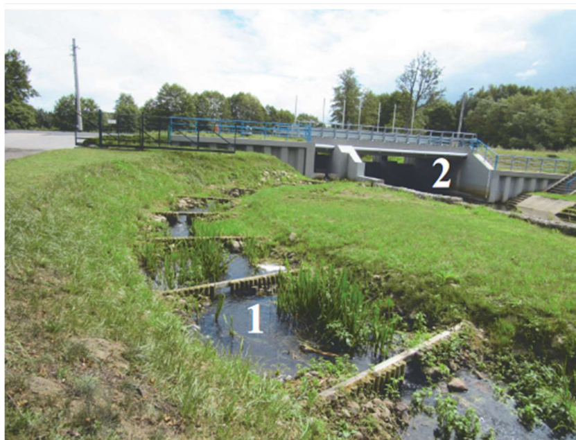
Fot. 26 Zabudowa poprzeczna przepławki palisadą drewnianą z oczepem (1-przepławka, 2-jaz). (źródło: https://ros.edu.pl/images/roczniki/2018/067_ROS_V20_R2018.pdf )
