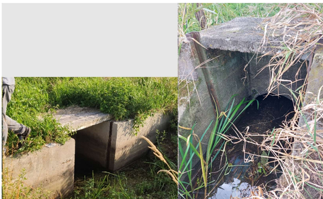
Fot. 8 Przepust z piętrzeniem o konstrukcji betonowej (źródło: opracowanie własne).
