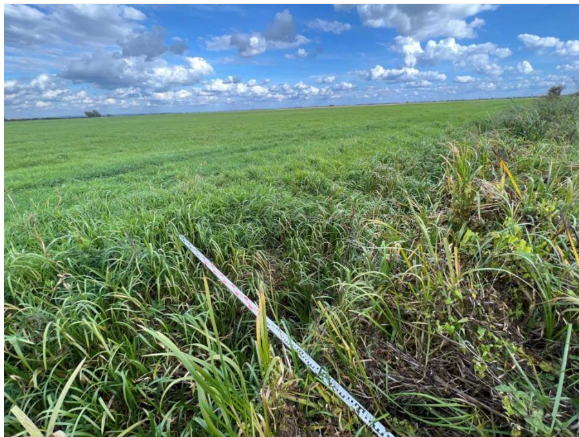
Fot. 14 Rów R1/kp18: nieutrzymany - zarośnięty; inwentaryzacja terenowa.
