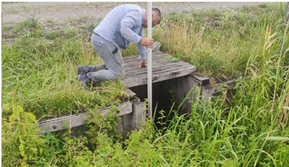
Fot. 7 Przepust z piętrzeniem o konstrukcji drewnianej (źródło: opracowanie własne).
